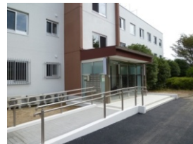
■玄関スロープ
