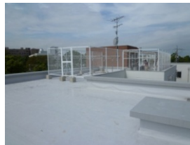
■外断熱遮熱シート防水
