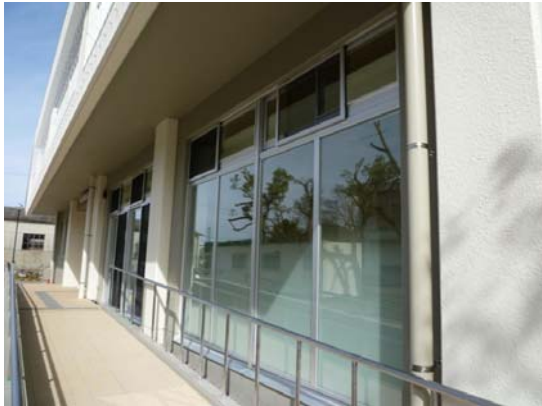
改修後玄関周辺
