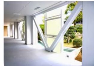
■北面耐震ブレース
