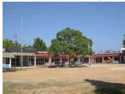
改修後幼稚園園舎
