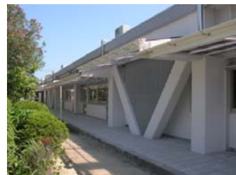
改修後園舎耐震補強
