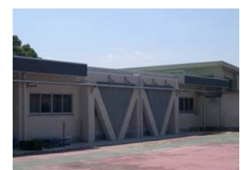
小学校校舎耐震補強
