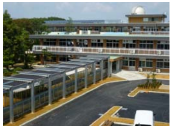
小学校校舎から改修後の中学校管理棟及び新設渡り廊下
