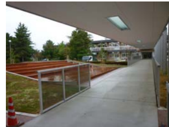
改修後中庭・コドール
