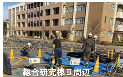
通信配線交換状況
