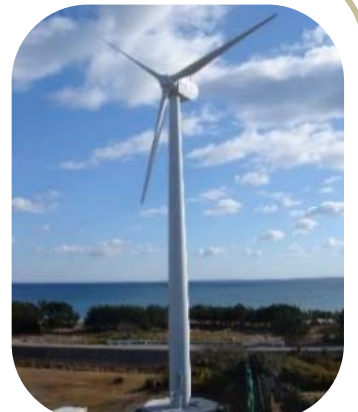
風力発電設備 (300kW)
