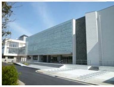
附属図書館改修 H24年度
