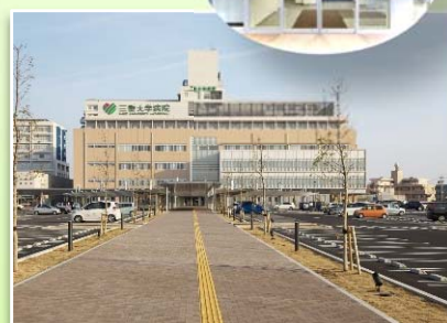
附属病医本館取り壊し、 駐車場整備 H28～29年度
