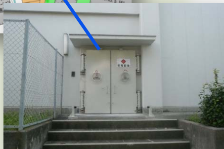
①特高変電所1階防水扉設置
