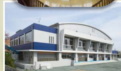
(観音寺) 附属小学校 屋内運動場改築 H25年度
