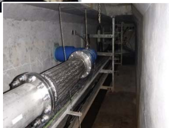
給水配管更新
