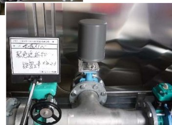
緊急遮断弁設置
