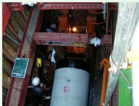
推進工法(泥水式)工事中
