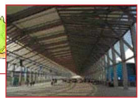
▲長久手会場の北エントランスデッキからひろがる 屋根付回廊。床、柱、天井のほとんどが木（廃棄材や スギの間伐材も使用）で作られています。
