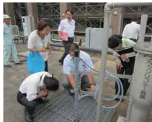
現場審査、生活排水処理施設の確認 (H26.10.02)
