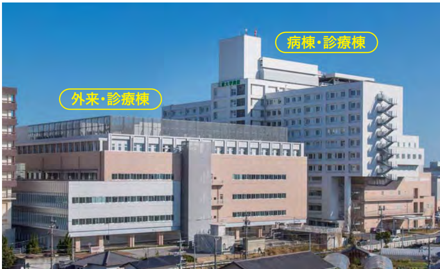
附属病院西側外観
