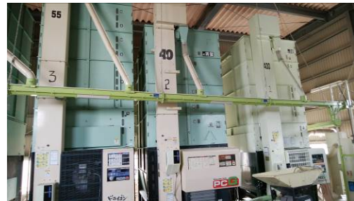
収穫調整施設調査
