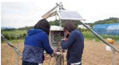
現場観測機器設置の様子
