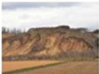
斜面崩壊現場例
