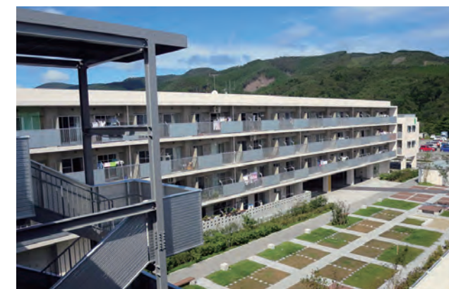
▲ 建設された災害公営住宅 (東北地方)
