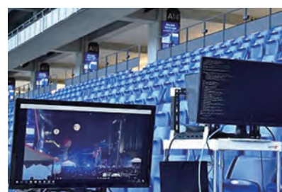
▲ 大型サッカースタジアムでの5G無線実験
