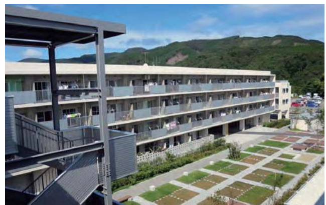
▲ 建設された災害公営住宅(東北地方)
