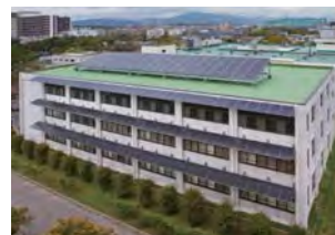
太陽光発電(附属図書館)
