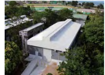
工学部実験実習棟屋根の遮熱塗料
