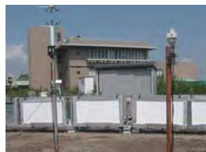
衣替え建築の実験(平成21年8月)
