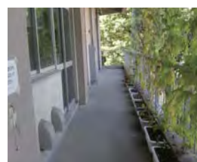
共通教育二号館 (平成22年8月18日)
