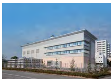
エネルギーセンター
