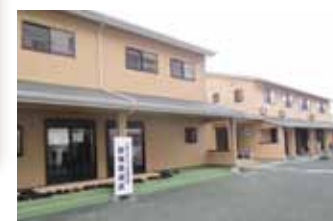
さつき保育園の新棟完成
