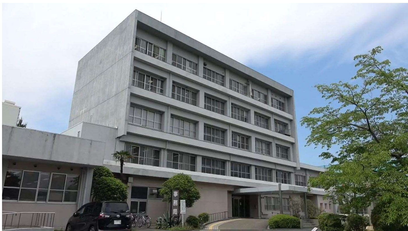
本部管理棟(改修前)
