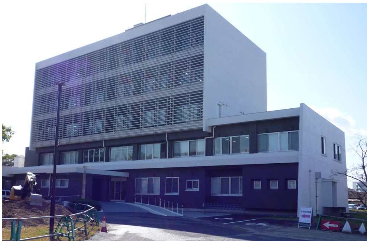
本部管理棟(改修後)
