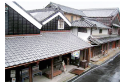
伊勢市河崎の町並み 日本の伝統的な住宅。屋根は瓦葺き、壁は土壁(外壁は、漆喰あるいは板張り仕上げ)。材料、寸法、部材構成、施工方法など、近年建設される住宅とは特徴が異なる。(図3)
