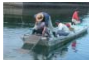
ゾステラマット設置作業
