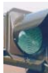
発光ダイオードを用いた信号機
