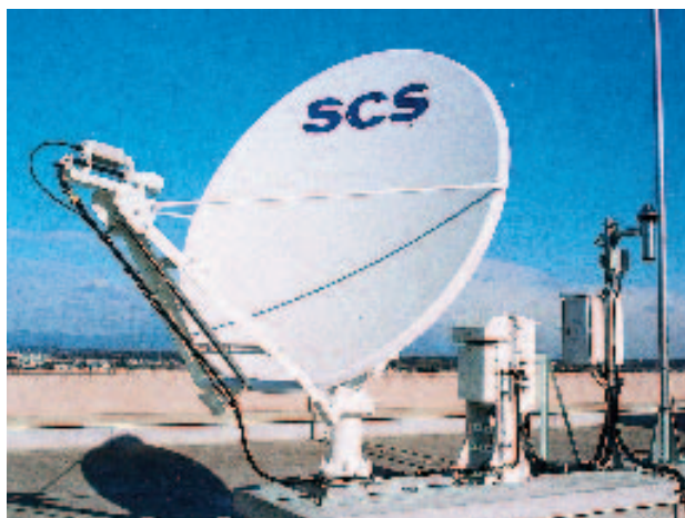
図 1. 生物資源学部屋上のパラボナアンテナ(直径:2.4m)と自動気象観測装置 Fig.1. Parabolic Antenna (diameter : 2.4 m) and Automatic Weather Observation Apparatus on the Roof of Faculty of Bioresources
