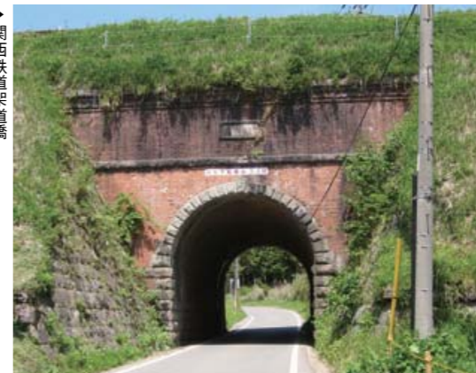
▶ 関西鉄道架道橋
