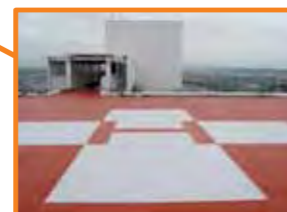
▲屋上ヘリポート建設状況
