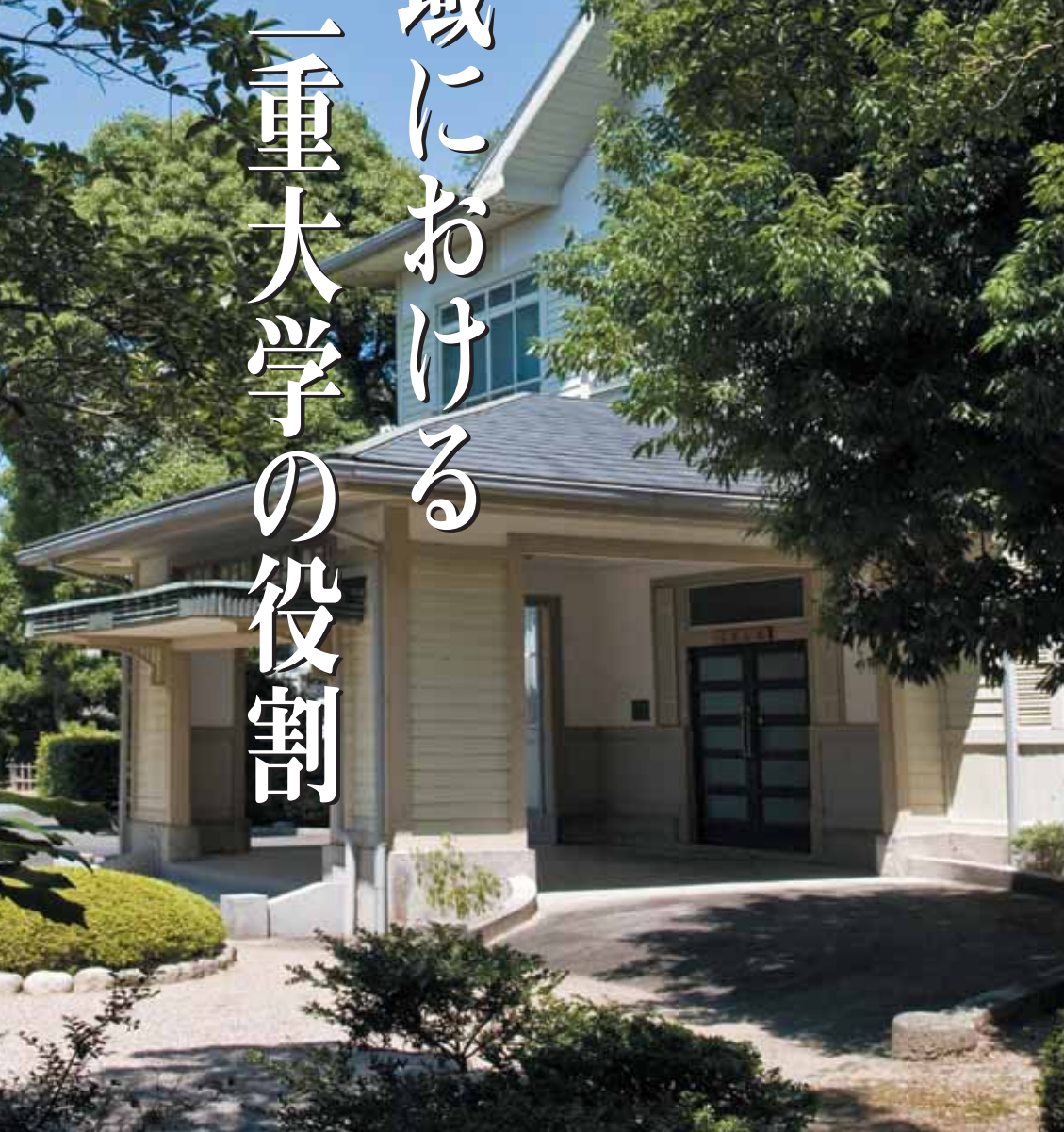
三重大学三翼会館 (1936年竣工、登録有形文化財)
