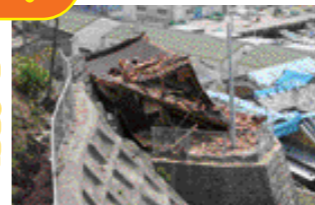
▲(玄界島)「福岡県西方沖地震」により倒壊した建物
