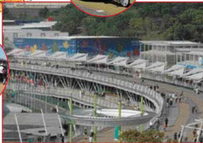
▲長久手会場をほぼ水平に一周できる空中の回廊「グローバル・ループ」 全長約2.6km、標準幅約21m
