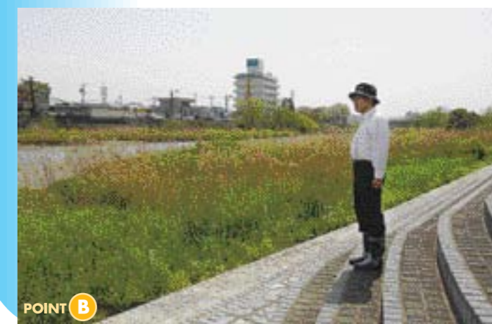
▲災害復旧工事により護岸工事がなされた安濃川(三重県警察本部前)
