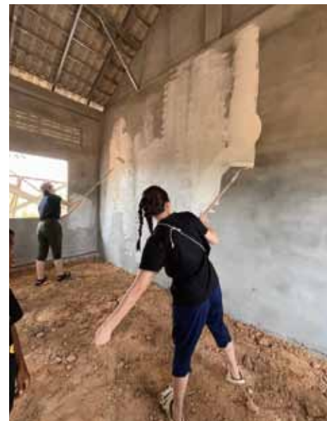
小学校の建設（ペンキ塗り）
