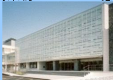
建物:附属図書館改修【6.0億円】H25.3完成
