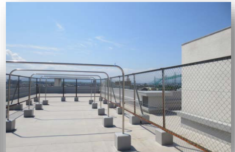
↑屋上(物干し場)
