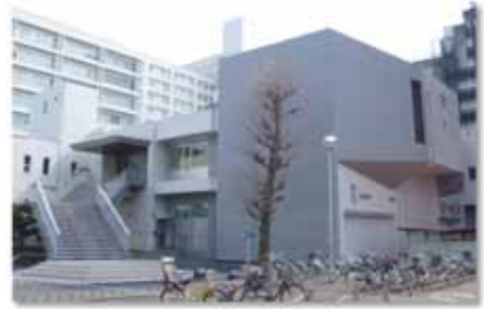
医学教育棟改修
