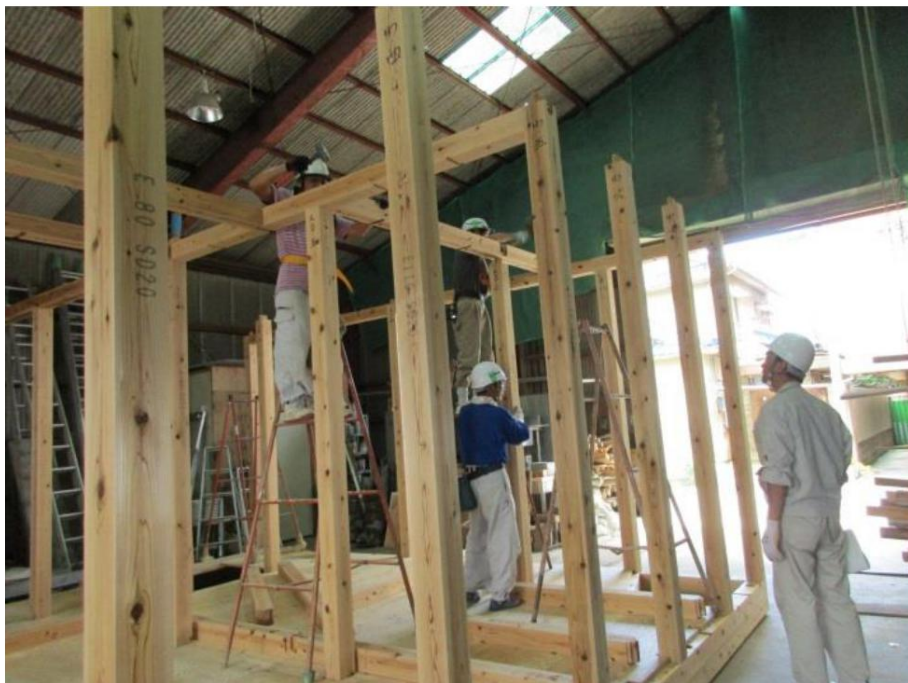
写真 4-1 柱の建込・梁の取付作業
