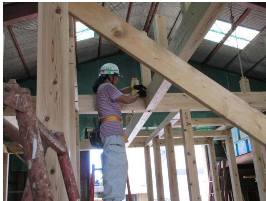
写真 4-2 羽子板ボルト締め付け
