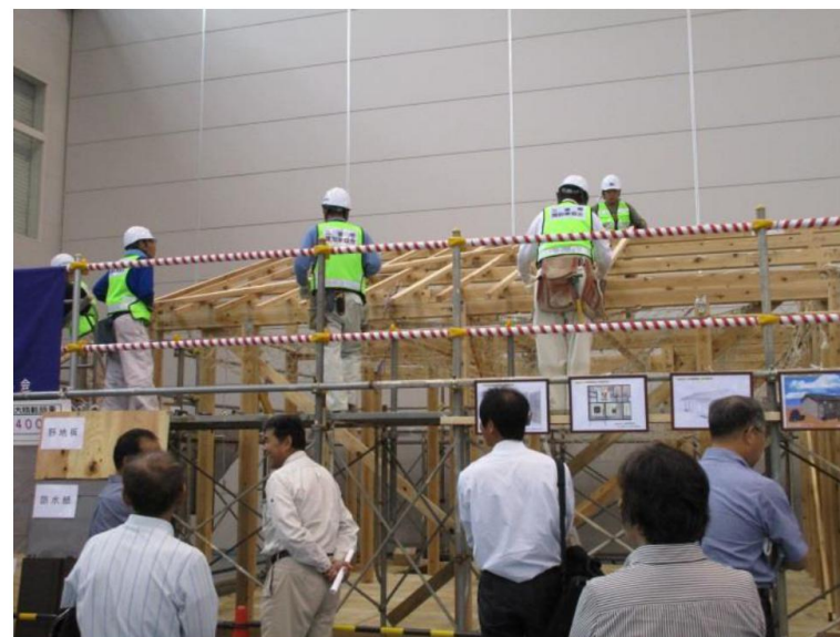
写真 4-6 屋根下地、タルキの取付
