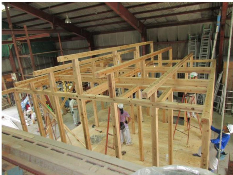
写真 4-3 母屋取付完了
