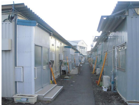
写真 2-1 山田中学校が部活で利用していた町民グラウンドにやむをえず 仮設住宅を建設した事例（岩手県山田町織笠団地：奥に見えるのは中学校の体育館）
