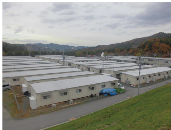
写真 1-1 金沢市平田総合運動公園における平田第6仮設団地の様子
