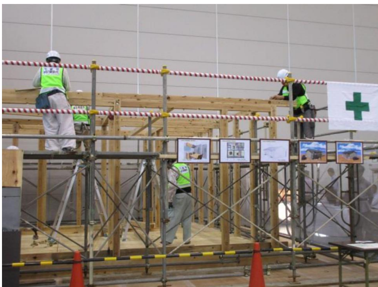
写真 4-5 桁の取付
