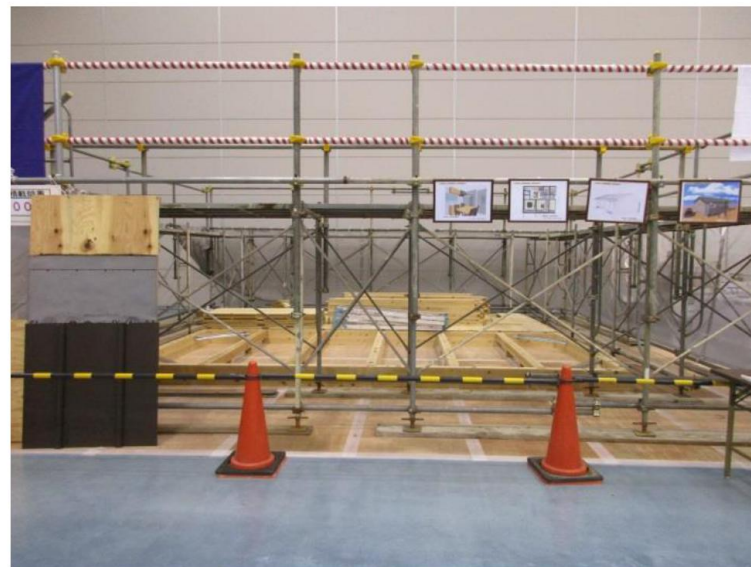
写真 4-4 床下地、大引き設置
